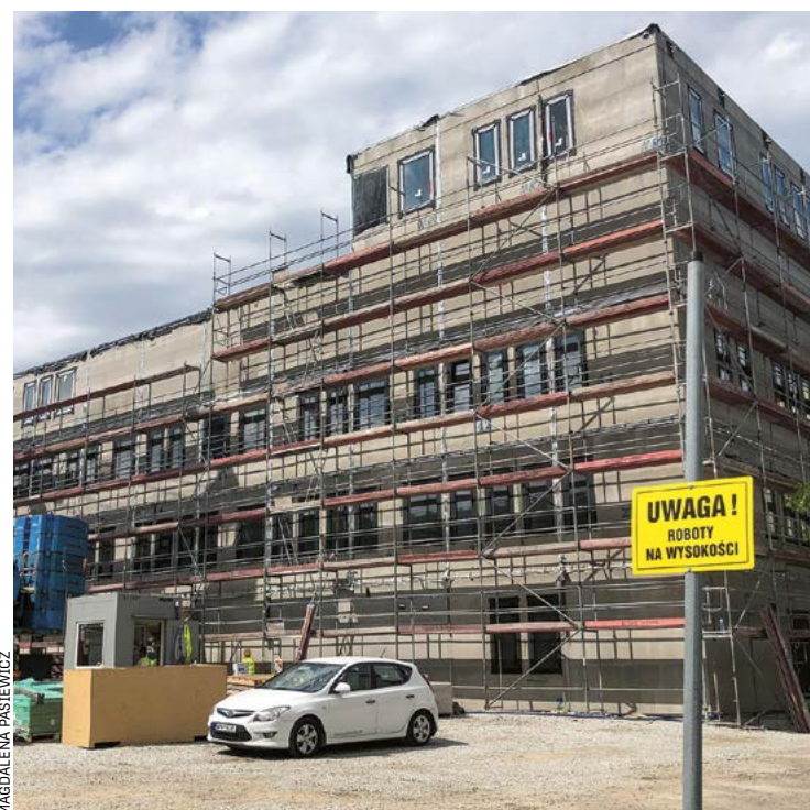
Prace przy budowie komisariatu Wrocław – Stare Miasto idą pełną parą
